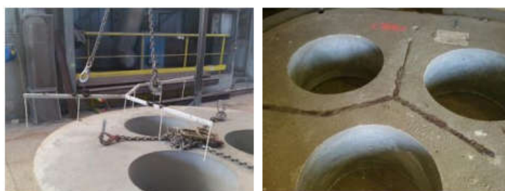
شکل 3: نصب ترموکوپل‌ها در دلتای سقف.
