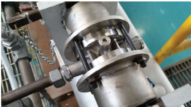
شکل 5- نصب نازل در کارخانه BIRLA COPPER
