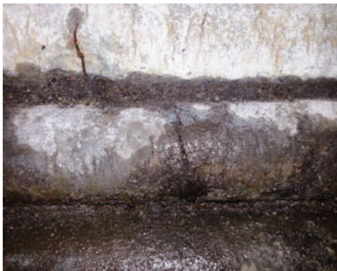
شکل 4- ترکهای عرضی ناشی از تابش قوس.
